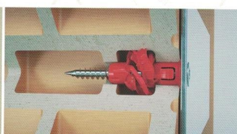
Монтаж в тухла
