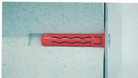
Монтаж в бетон
