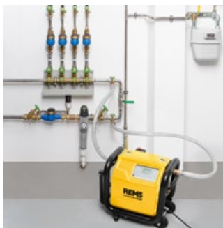
Промиване на инсталации за питейна вода
