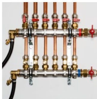
Промиване на радиаторни и панелни отоплителни системи
