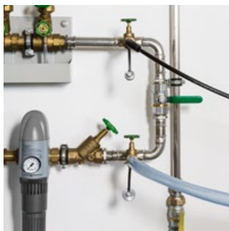
Изпитване на налягане с вода
